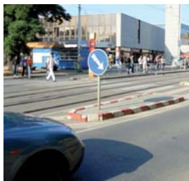
Přechod s dělicím ostrůvkem v Plynární ulici
