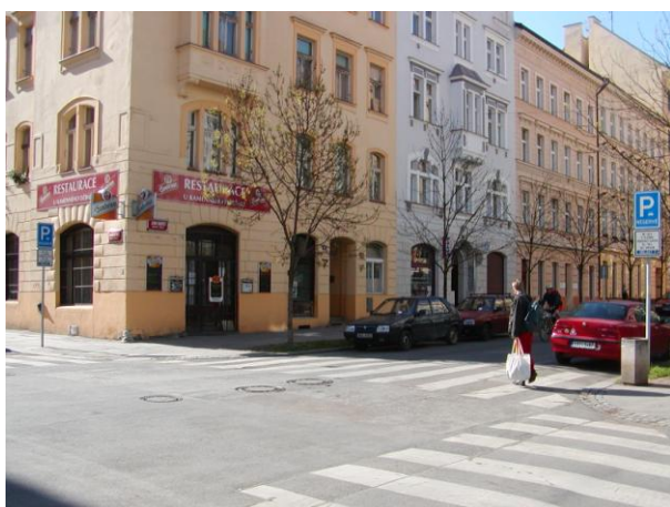
Jana Zajíce - Havanská, vstupní šachty kanalizace
