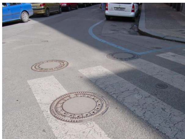
Vstupní šachty kanalizace a uliční vpusti
