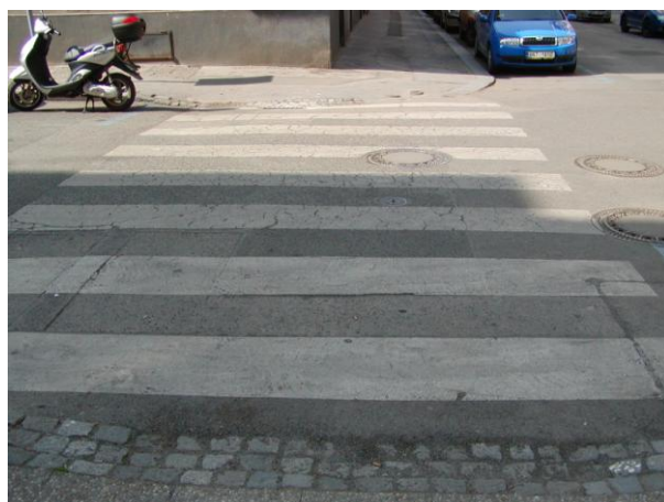
Stávající přechod, chybějící hmatné úpravy
